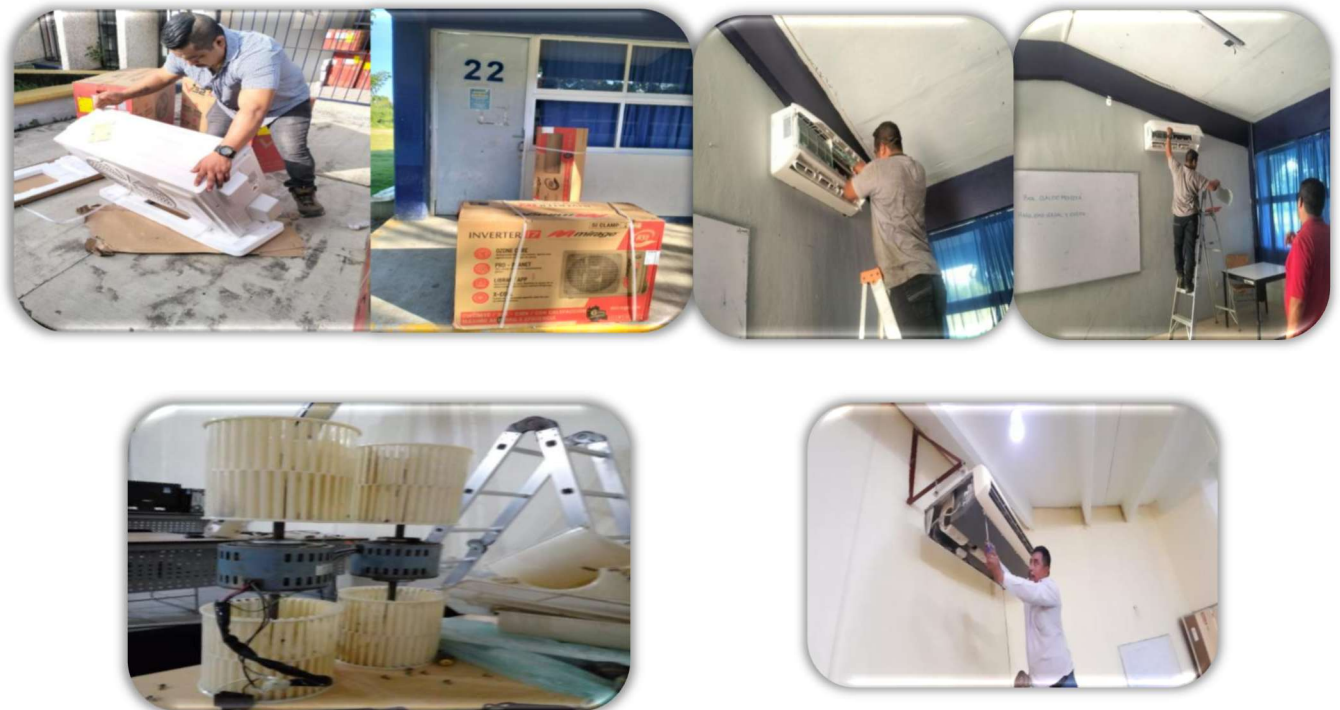
Imagen 38 a la 43 Mantenimiento a mini Split.
