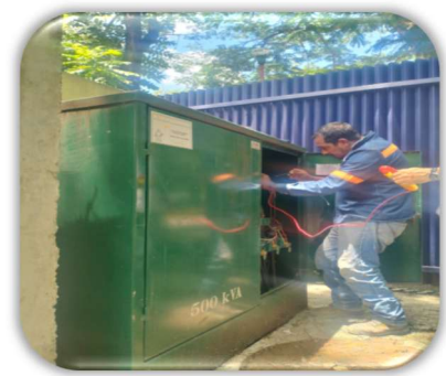
Imagen 92 a la 94 Mantenimiento al transformador eléctrico.
