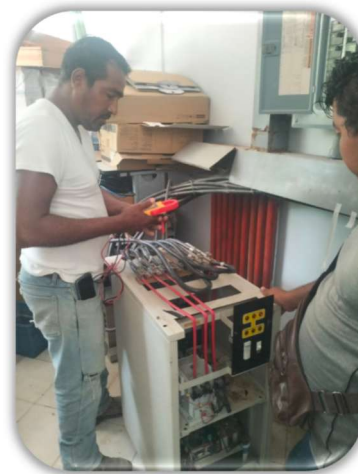
Imagen 98 a la 102 Mantenimiento al tablero de control eléctrico - laboratorio de cómputo.
