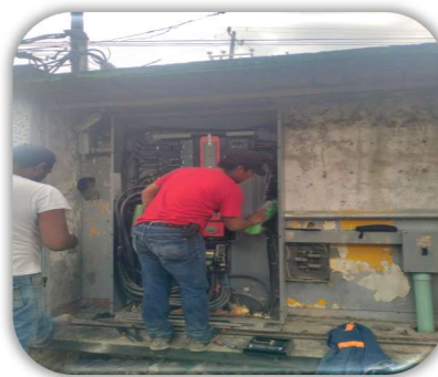
Imagen 92 a la 94 Mantenimiento al transformador eléctrico.
