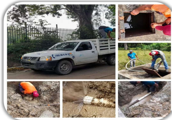
Imagen 56 a la 57 Mantenimiento a red hidráulica.
