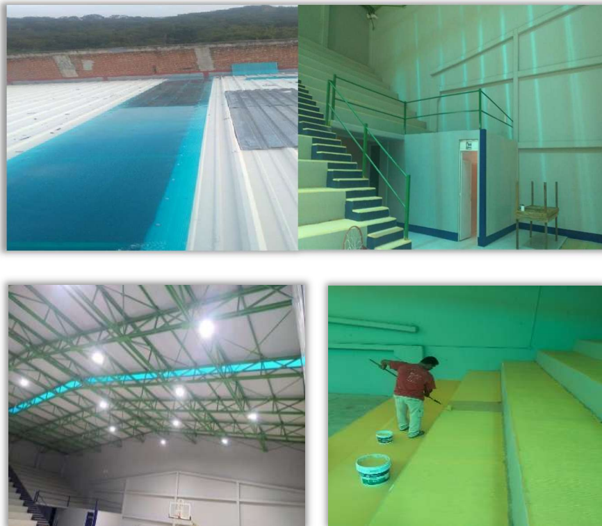
Imagen 140 a la 143 Rehabilitación a techumbre, gradas y lámparas de gimnasio auditorio.
