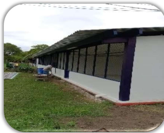
Imagen 48 a la 50 Mantenimiento a nave avícola y canícula.
