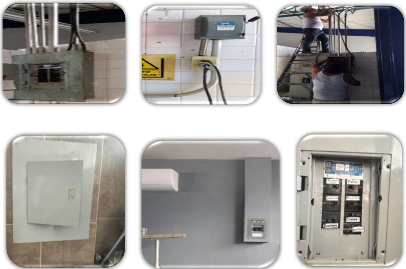
Imagen 80 a la 85 Mantenimiento al subministro eléctrico.
