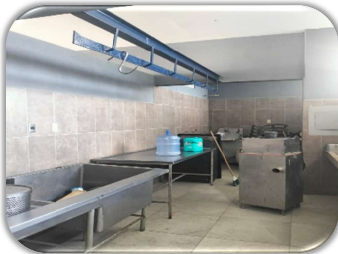
Imagen 76 a la 79 Mantenimiento al taller de carnes.
