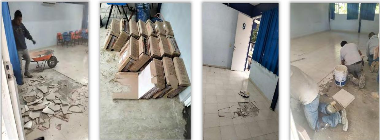
**Imagen 62 a 65 Retiro de loseta y colocación de loseta nueva.**
