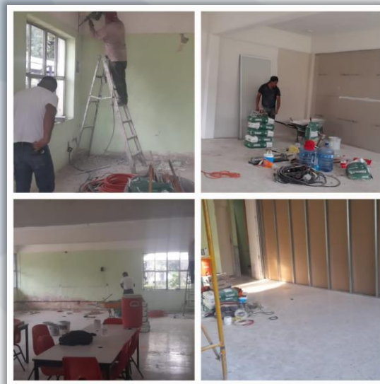
Imagen 16 Mantenimiento de aula
